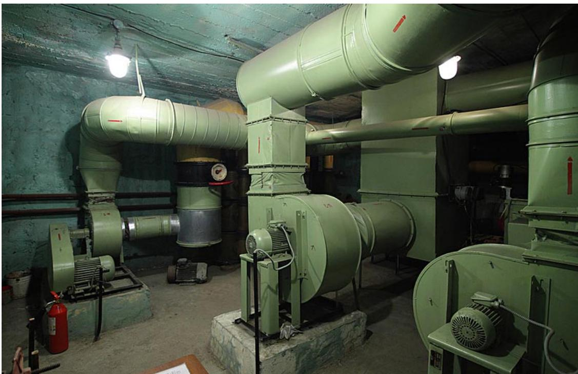
Рисунок 18 – Система воздухообеспечения защитного сооружения
