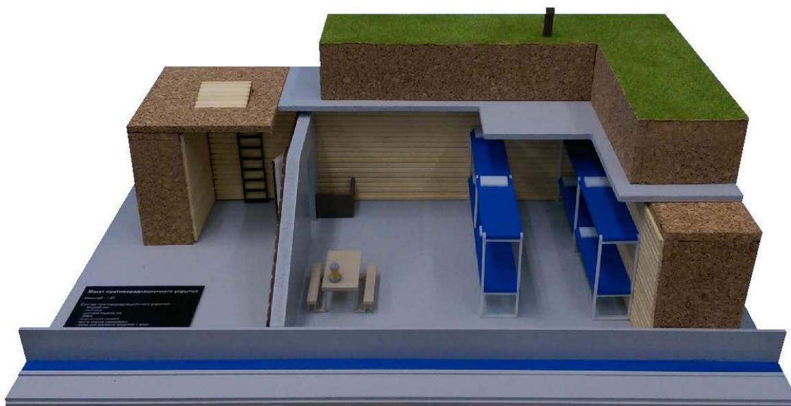
Рисунок 19 – Макет быстровозводимого противорадиационного укрытия (на 25 человек)
